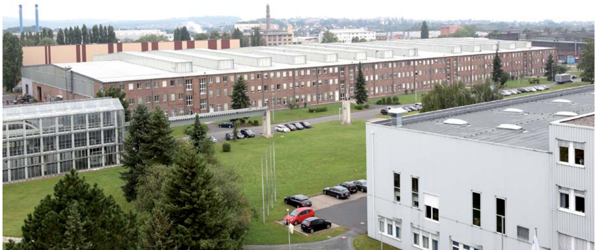
Blick auf den von der RGM ExperSite GmbH betriebenen 50 Hektar großen Industriepark Kassel-Mittelfeld.
